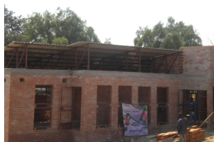
Schulbau, das Dach ist drauf
